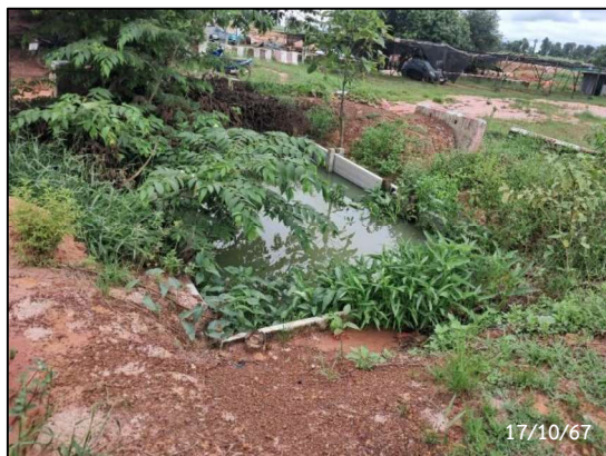
รูปที่ 2-73 บ่อพักน้ำและทางระบายน้ำโดยรอบพื้นที่สำนักงานก่อสร้างและบ้านพักคนงานก่อสร้าง
