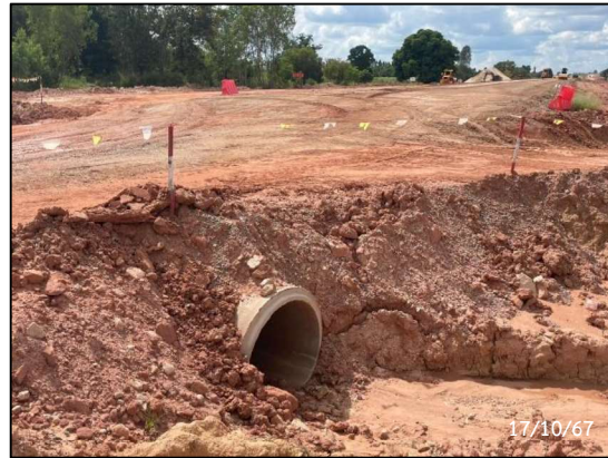
รูปที่ 2-70 การติดตั้งท่อลอดคอนกรีตกลมเพื่อระบายน้ำ
