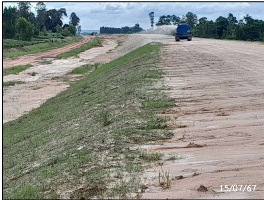
รูปที่ 2-80 การขุดดินให้เป็นแนวลาดเอียง ปลูกพืชคลุมดิน เพื่อป้องกันการพังทลายของดิน
