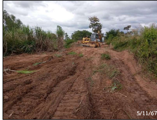
กม.210+250 ถึง กม.210+380 รูปที่ 2-140 (ต่อ) กิจกรรม Clearing Haul Roads
