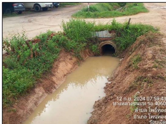
รูปที่ 2-73 บ่อพักน้ำและทางระบายน้ำโดยรอบพื้นที่สำนักงานก่อสร้างและบ้านพักคนงานก่อสร้าง
