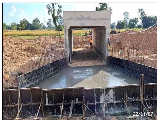
รูปที่ 2-43 การก่อสร้างทางลอด (Box Underpass)
