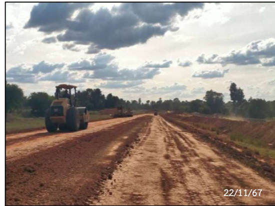
รูปที่ 2-77 กิจกรรม Prepared Subgrade กม.32+000-33+000
