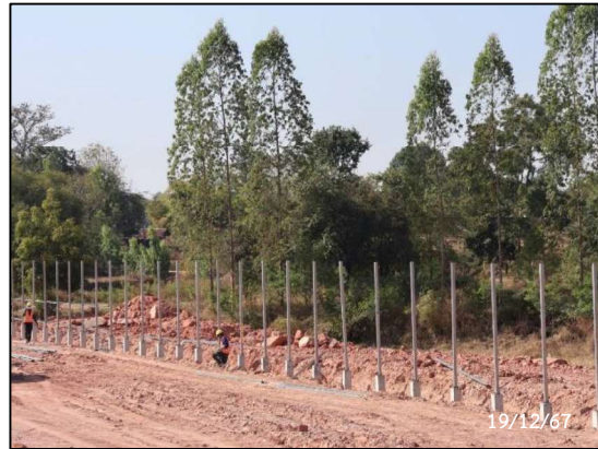
รูปที่ 2-87 การติดตั้งกำแพงกันเสียง
