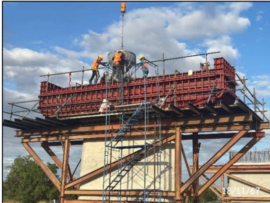
รูปที่ 2-82 กิจกรรม ก่อสร้างฐานรากสะพานรถไฟ ช่วงกม. 64+500-กม. 65+594 โดยใช้เสาเข็มเจาะ
