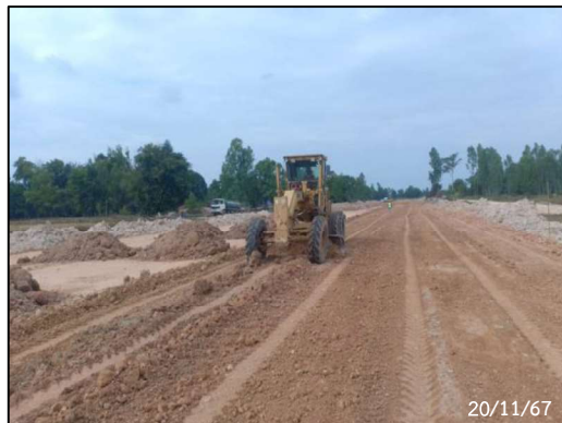
กม.299+860 ถึง กม.303+100 รูปที่ 2-142 กิจกรรม Embankment Fill
