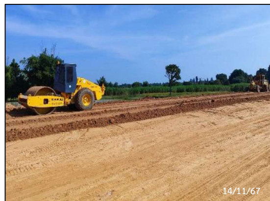
รูปที่ 2-34 กิจกรรม Embankment Fill
